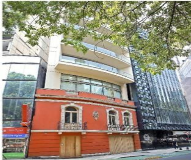
■ Ejemplo de fachadismo en Paseo de la Reforma 326; se mantiene la fachada patrimonial pero el inmueble crece en pisos.
