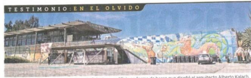
La maleza invade actualmente el Faro de Oriente, un edificio en forma de barco que diseñó el arquitecto Alberto Kalach.
